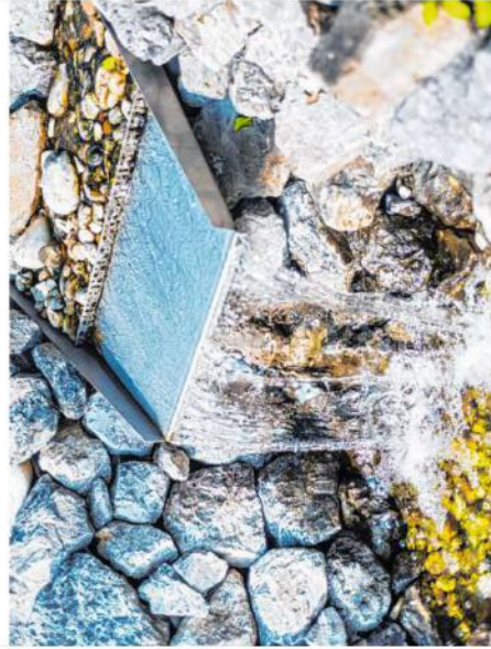
Die Edelstahlwanne erzeugt einen Wasserfall zwischen den Kiesbecken
